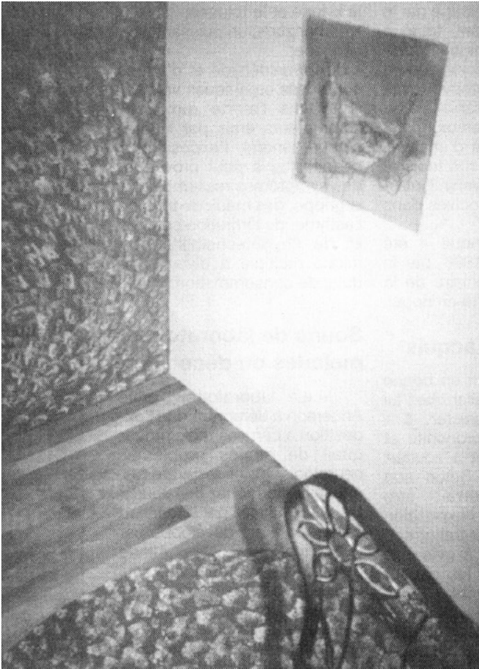
Une maison écologique n'a pas besoin d'avoir l'air de «la chienne à Jacques», dit Donald Thériault. Plancher de bois et de terre peinte, rampe en fer forgé et coupe de mur démontrant la paille.
